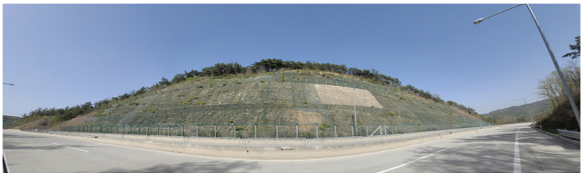
상주절토 35 (관리이정 0.160~0.42km / 6공구 STA.0+160~0+420(이설도로#2))
