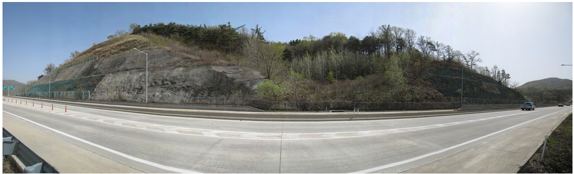
영천절토 34 (관리이정 1.890~2.150km / 5공구 군위R-A(중양)STA.1+890~2+150)
