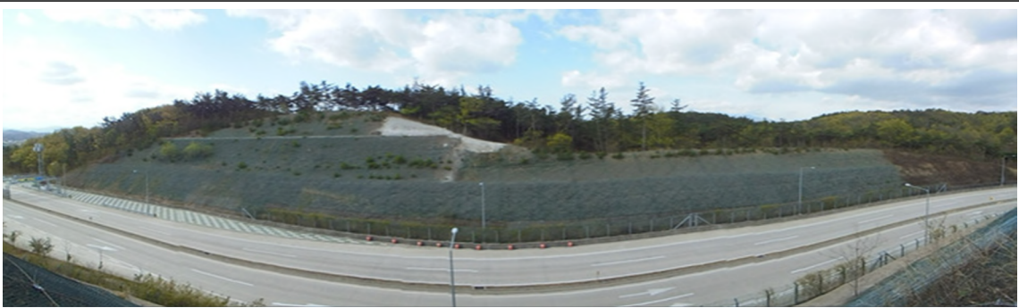
영천절토 59 (관리이정 1.600~1.723km / 8공구 화산JCT RA좌측 STA.1+600~1+723)
