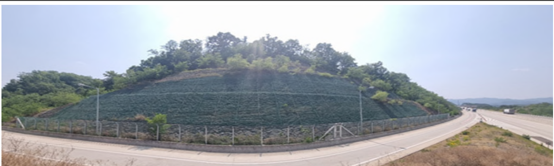
영천절토 60 (관리이정 0.140~0.260km / 8공구 화산JCT RD우측 STA.0+140~0+260)
