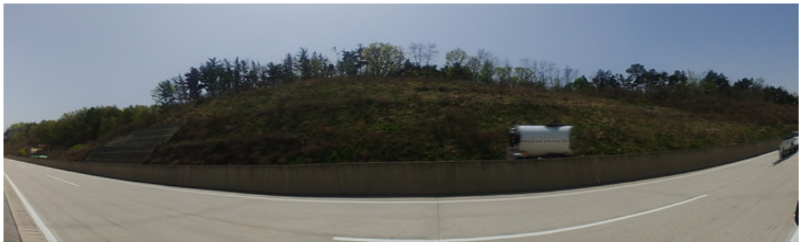
상주절토 07 (관리이정 도개IC R-A 0.070~0.330km / 2공구 도개IC R-A 0.070~0.330km)
